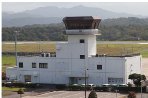
▲現在は使用されていない萩・石見空港の管制塔。
